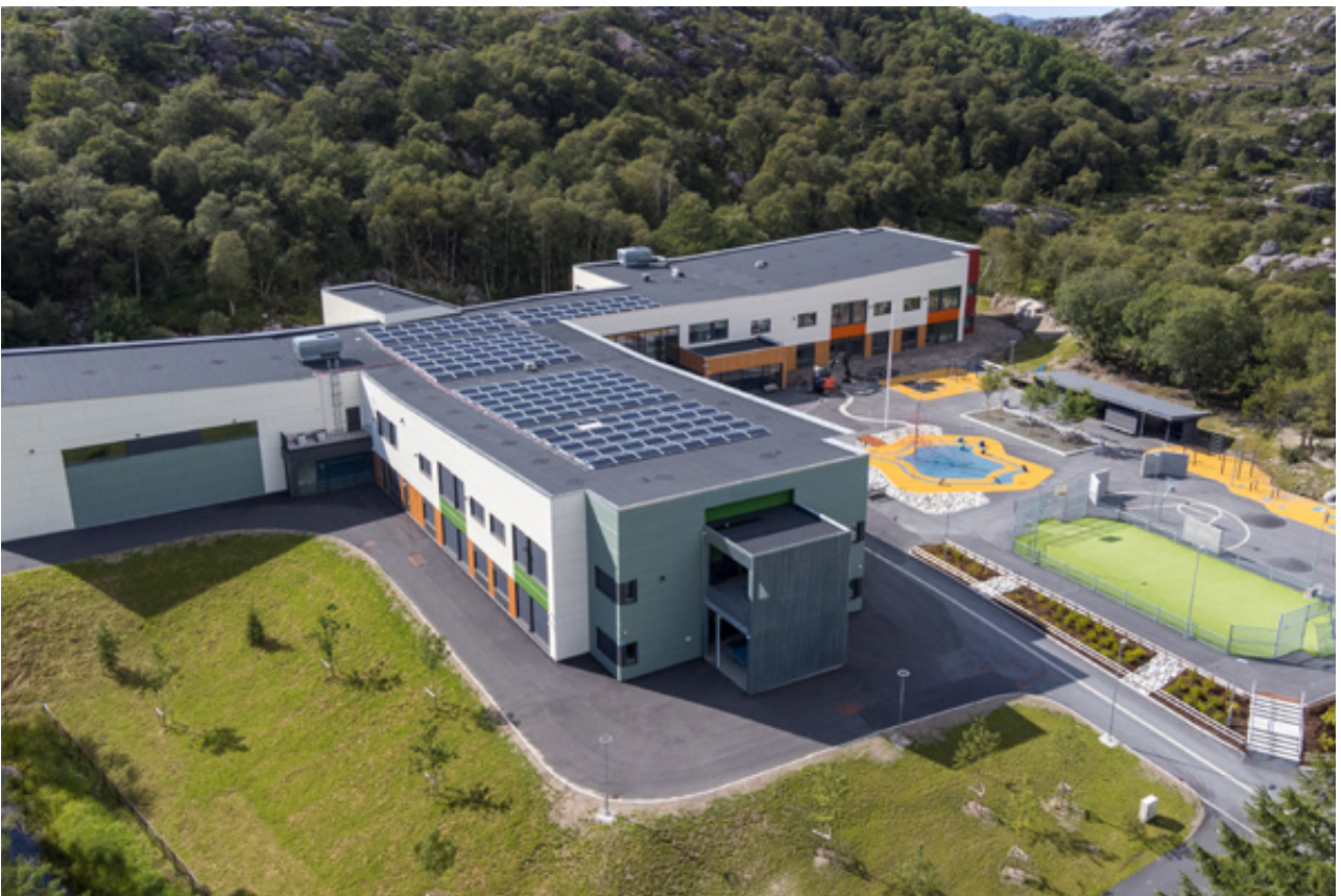
Like ved Håå ligger det den nye barneskolen.
